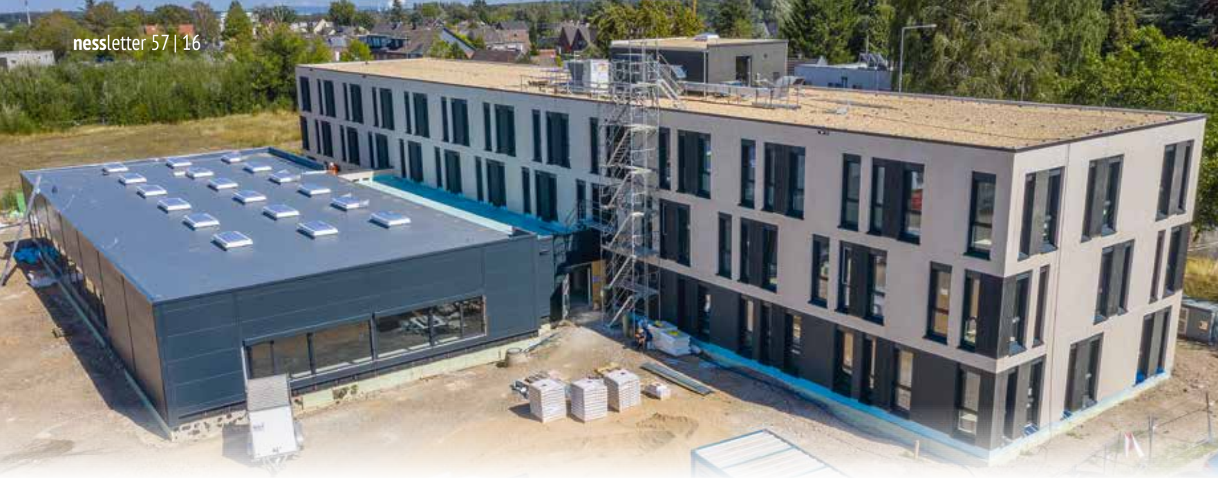
Kurz vor der Fertigstellung: das n.office-Gebäude in der Aachener Nordstraße.
