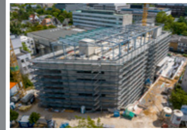
Prosektur Uniklinik Gleueler Straße, 50931 Köln Fertigstellung März 2025
