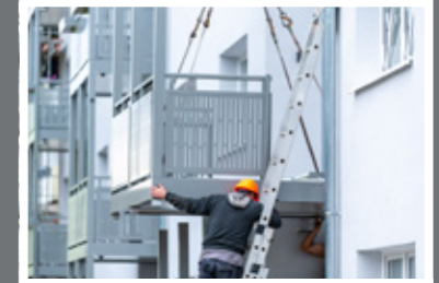
Modernisierung Holweide Piccoloministraße, 51067 Köln Fertigstellung Juni 2025
